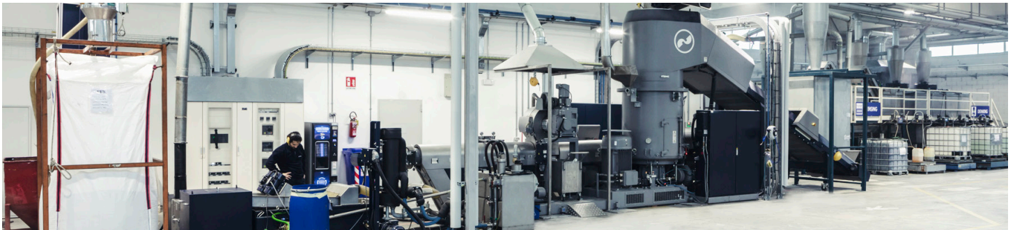
A linha de reciclagem na fábrica de Santa-Margherita, Itália, onde os sacos são separados, lavados, destintados e repetizados para se tornarem um produto reciclado premium.
